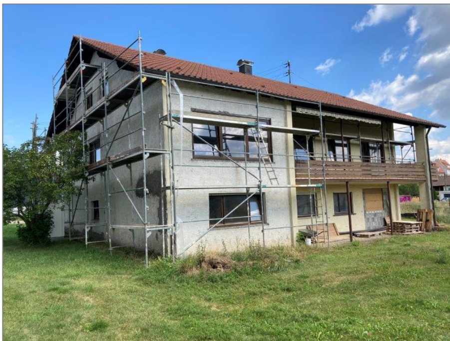
Abb. 4: Eingerüstetes, derzeit saniertes Wohnhaus (Foto: HPC AG 16.08.2022)
