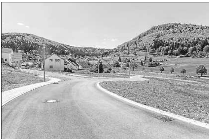
Der Gemeinderat hat die Bauleistungen für den Endausbau „In der Breite, 1. Bauabschnitt“ (linkerhand) in Oberdigisheim vergeben. Fertig ist der Bereich „In der Breite, 2. Bauabschnitt“ (im Vordergrund). Foto: Volker Bitzer
